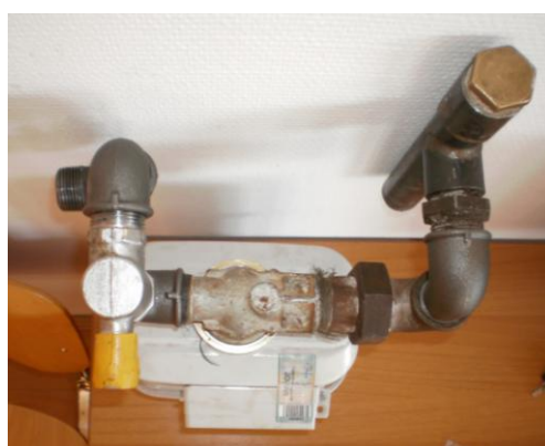
M2/2-13. ábra: Meglévő gázmérőkötés átalakításakor alkalmazandó megoldás, elrendezés
