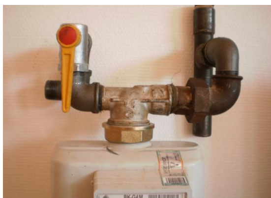
M2/2-13. ábra: Meglévő gázmérőkötés átalakításakor alkalmazandó megoldás, elrendezés
