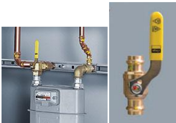
M2/2-7. ábra: Példa a réz anyagú fogyasztói vezeték kialakítási lehetősége
